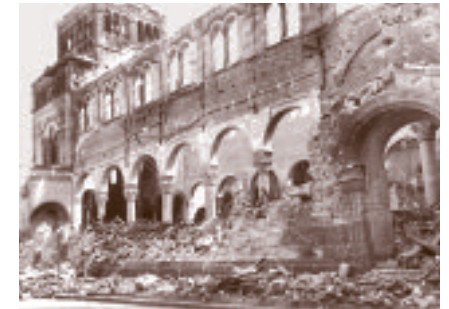
Die zerstörte St. Adolphus-Kirche in Düsseldorf nach dem Luftangriff am 23.4.1944
