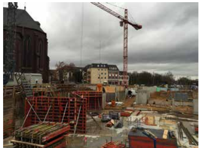
Pfarrzentrum St. Jacobus, Januar 2015 - erste Wände werden errichtet.
