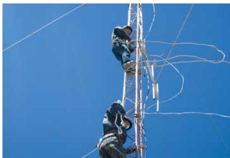
Installation der Antenne Foto: Projektpartner
