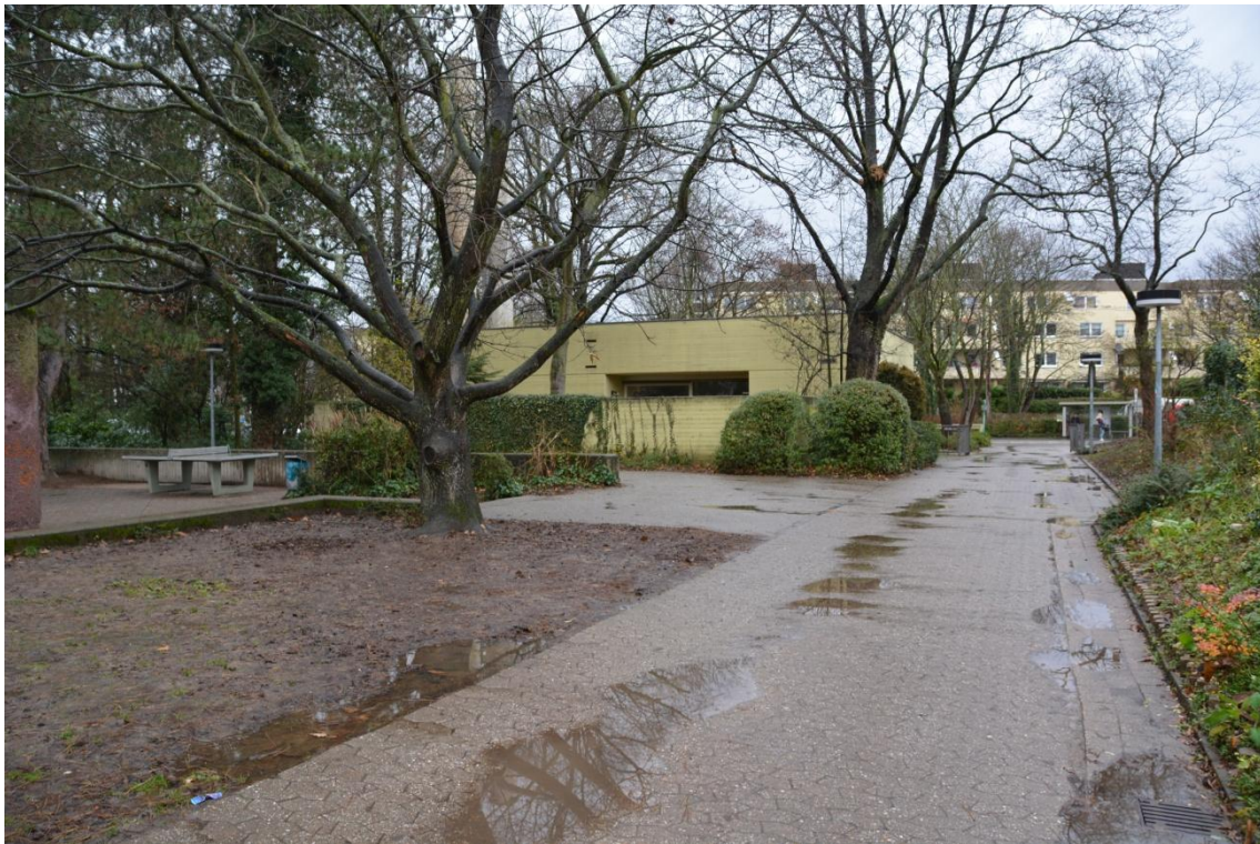
Abbildung 1: Blick vom Schulhof auf die Wohnung
