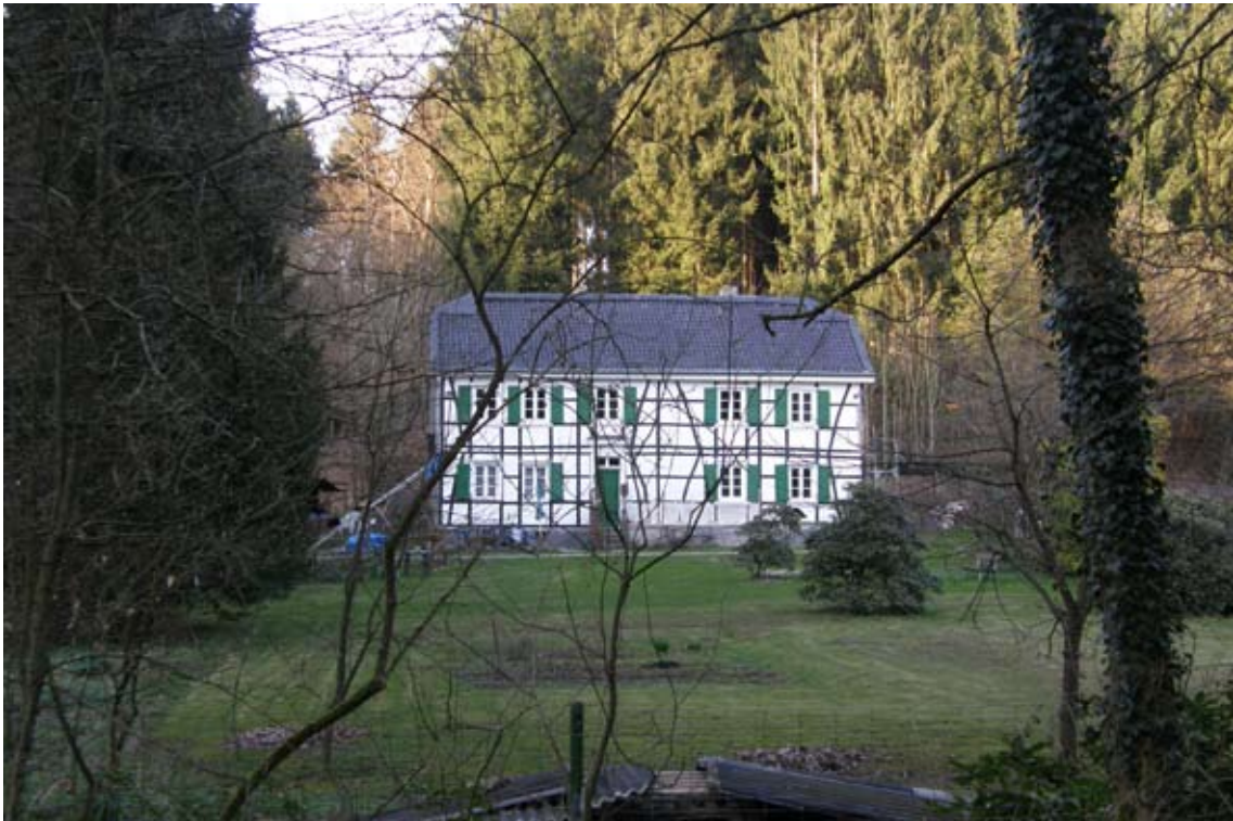
36.) Fachwerkhaus vor Gabelung (s. Nr. 9)
