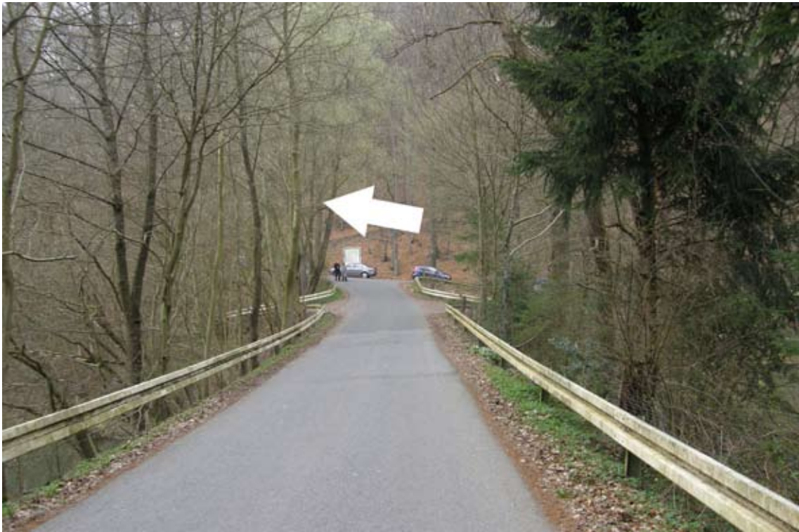
12.) am Ende bei Wandertafel links zur Straße
