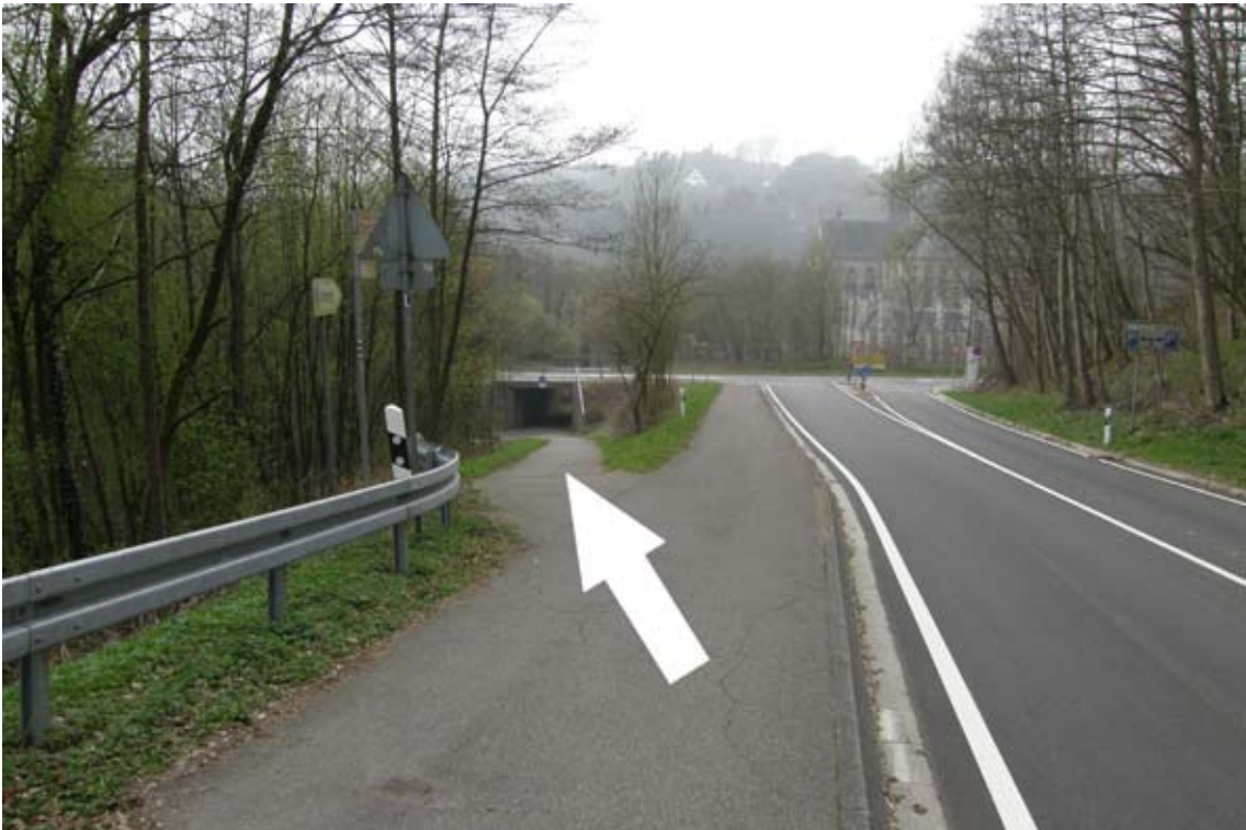
14.) durch die Unterführung zum Dom
